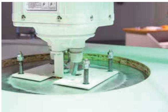
Zur Funktion der Revisionsabdeckung muss der Abstand von der Unterkante der Decke zum unteren Liftteller genau justiert werden. Zur exakten Anpassung wird der variable Montagebügel MB-V empfohlen.
